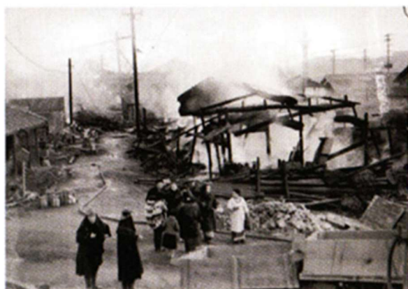
禁野火薬庫の爆発で家屋が倒壊した枚方町の様子
