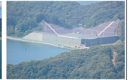
▲舞鶴「US-Only Area」米軍ミサイル倉庫
